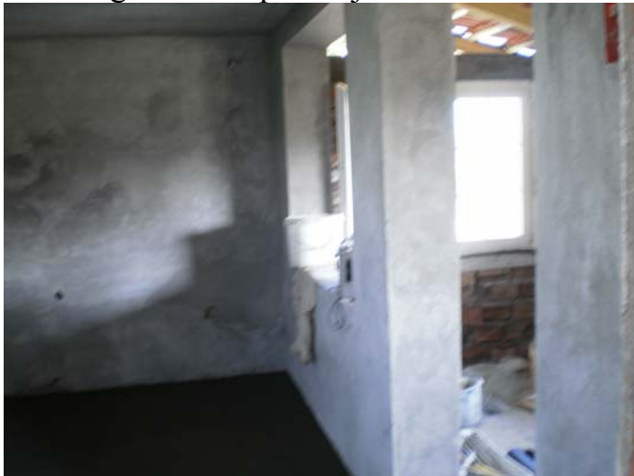
Ožbukana kuhinja, nedovršena soba za kćerke, podna glazura u radu 9.10.2010. u kuhinji.
